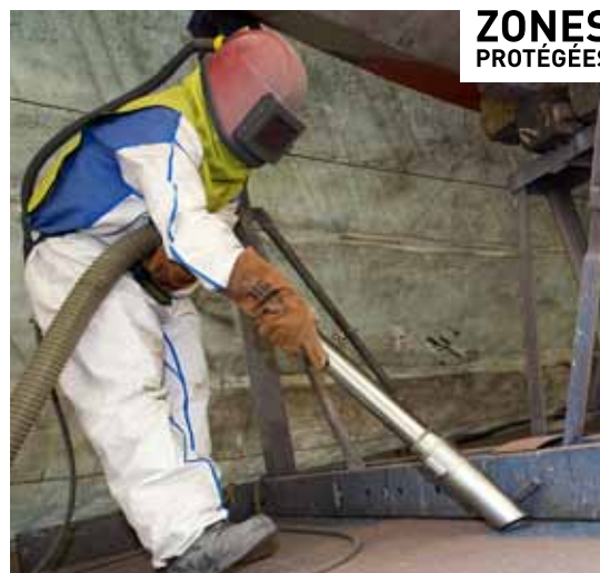
Juste après le ponçage, les poussières sont aspirées pour laisser une aire de travail propre et saine.
