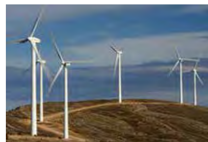
En 2016, l'entreprise investira dans une centrale éolienne à Yaté avec ce type d'appareils.
