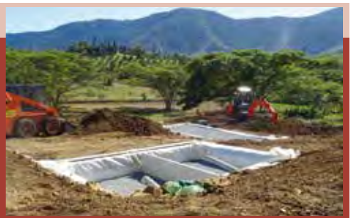
Filtres à écoulement vertical et horizontal en cours de réalisation (à Deva, Bourail).
