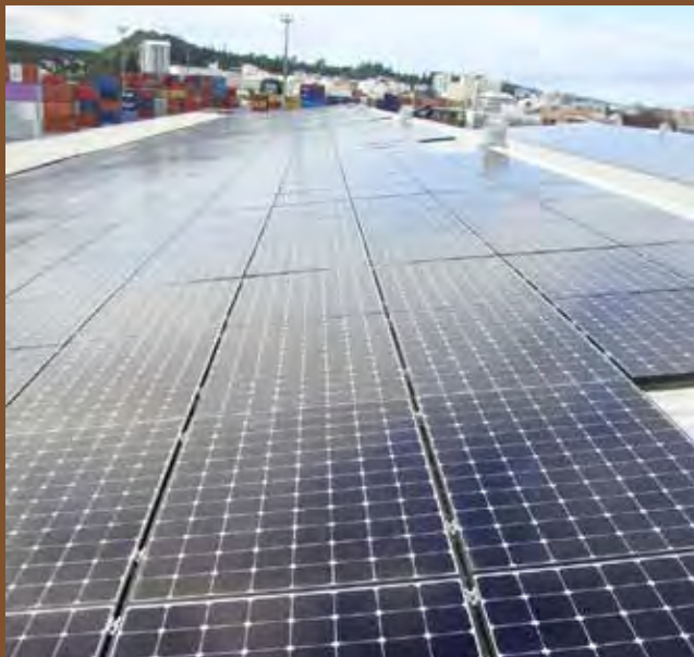
L'installation en toiture du Port autonome.
