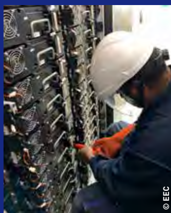
Pose des 800 batteries de stockage dans les conteneurs réfrigérés.
