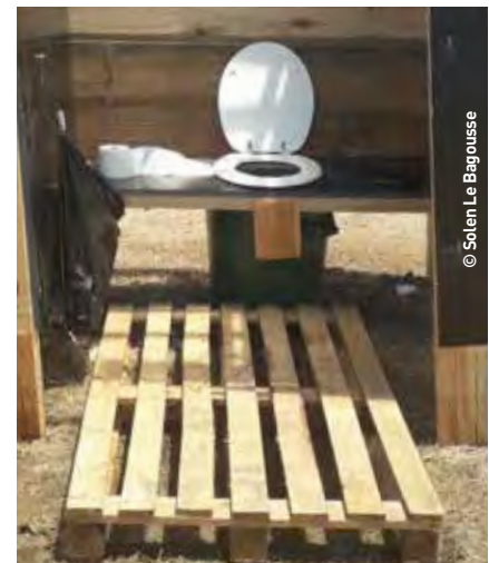
Les toilettes sèches pourront être réutilisées.
