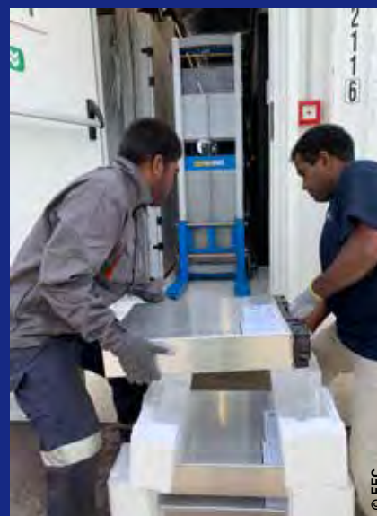
Pose des 800 batteries de stockage dans les conteneurs réfrigérés.
