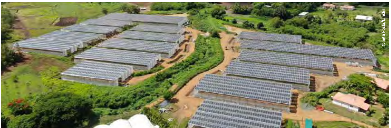
Le projet Focola est le premier exemple d'Agrienergie® en Nouvelle-Calédonie.
